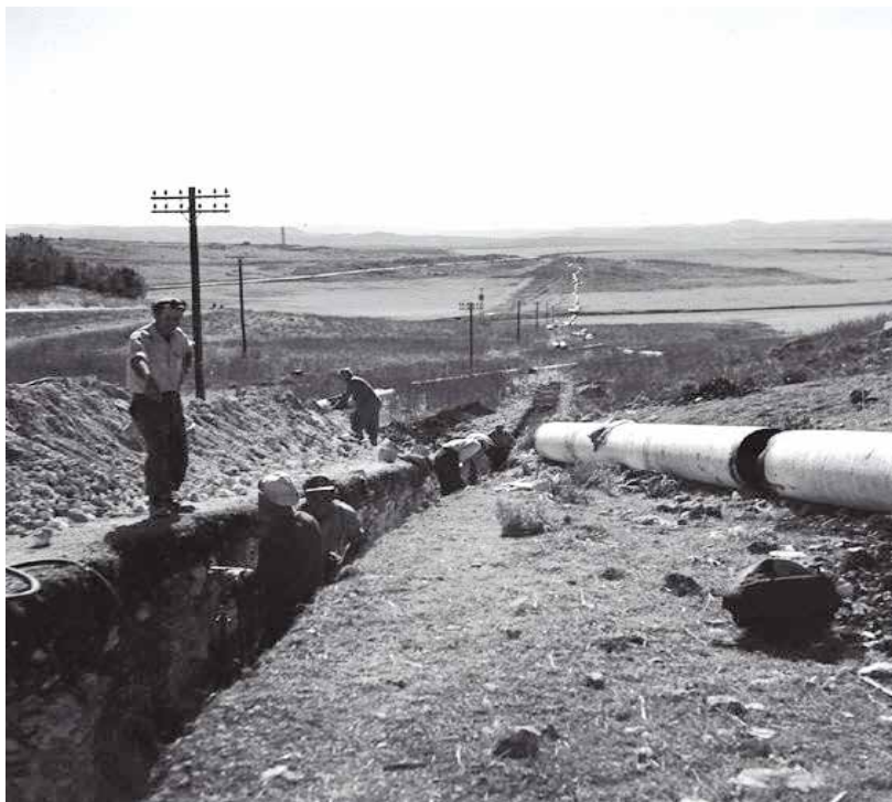
Construcció de canalitzacions vora Jerusalem, c. 1946.
